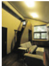
左上に見える屋根を支える梁と中2階に続く階段
