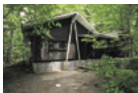
白いA型の柱が屋根の梁を支える
